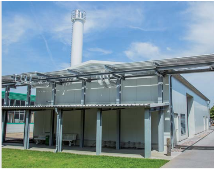
Außenansicht des Kesselhauses von Valenzi
